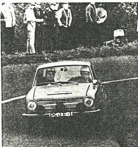
Gut 100 PS leistete der Renn-Glas, dessen Vierzylinder der erste deutsche Motor mit Zahnriemen im Renneinsatz war.
